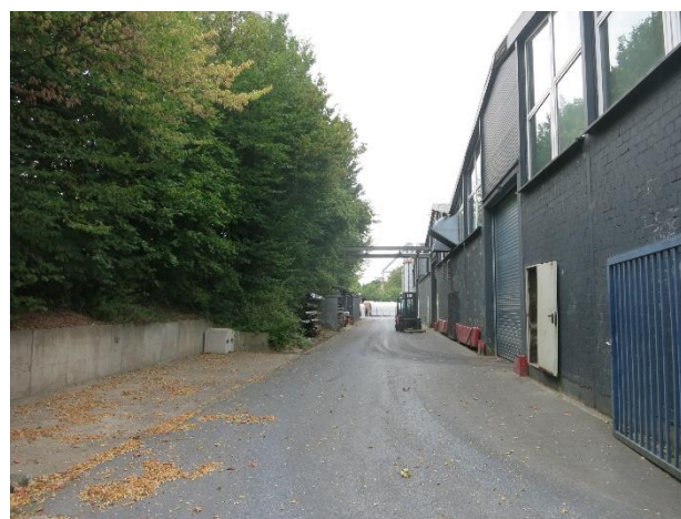
Blick von Nord nach Süd entlang gehölzbewachsener Böschung im künftigen GI
