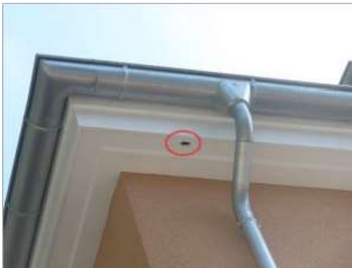
Abb. 10 Die Öffnung im Traufekasten ermöglicht Fledermäuse Zugang zum Dachkasten Quelle: BUND Niedersachsen
